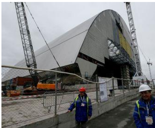
Fig 8: La konstruata sarkofago vidata de-interne. Ĉe la fundo, la malnova centralo kun la unua sarkofago.
