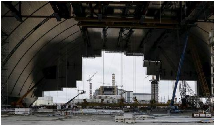
Fig 8: La konstruata sarkofago vidata de-interne. Ĉe la fundo, la malnova centralo kun la unua sarkofago.
